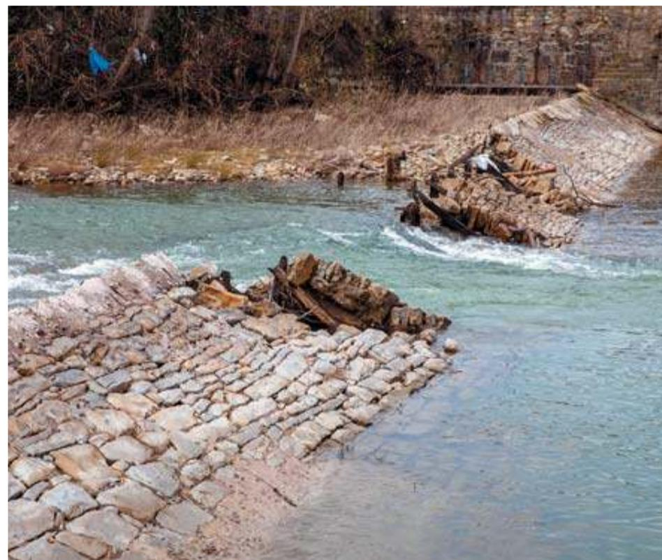
Detalle de la rotura, que deja al descubierto el entramado de madera.
